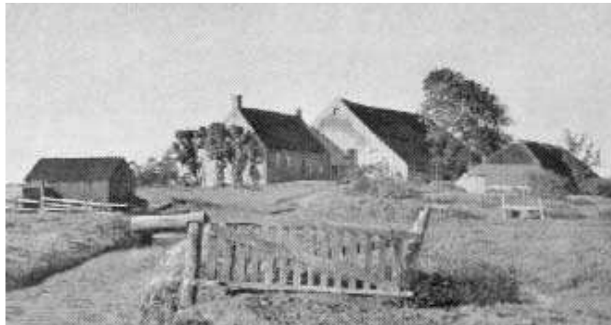
Abb. 1 Plaats-Gebäude bei Engerhufe in Ostfriesland. Die ältere Hausanlage des ostfriesischen Hofes (Plaats) zeigt zwei Bauteile: Wohnhaus und Gulfscheune. Bei dieser tragen zwei Reihen hoher Ständer das Dach. Das Gulfhaus mit großem Erntebegrungsraum in den durch zwei Ständerpaare begrenzten Gulfen entstand, als der Kornbau in den Marschen im 16. Jahrhundert starken Auftrieb erfuhr.
