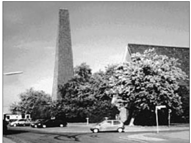
Die Versöhnungskirche an der Ecke Hermann-Tast-Straße/ Berliner Straße entstand nach dem 2. Weltkrieg im neuen Stadtteil Husum Nord. Unmittelbar westlich von dem Standort der Kirche befanden sich Abstellflächen und Rollbahnen des alten Flugplatzes Schauendahl.
